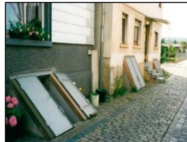
links: Abdichtung eines Kellerabgangs, rechts: Abdichtung von Fenster Quelle: LfU. (306.1-307.1)
