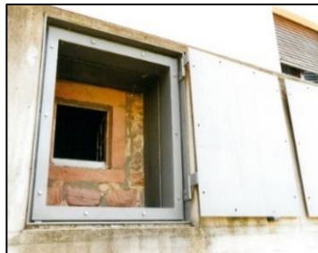
links: Abdichtung eines Kellerabgangs, rechts: Abdichtung von Fenster Quelle: LfU. (306.1-307.1)
